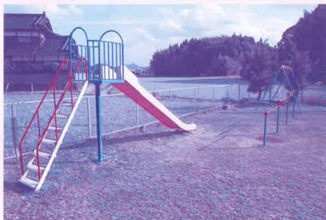
▲遊具補修工事業 (木須町木須東区)
