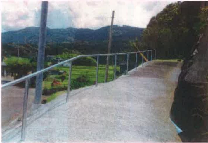
▲楠久区（山代町）茅野地区集会場安全柵（手摺）設置工事事業
