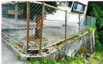
▲工事前の写真
